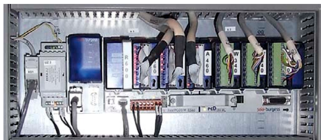
Saia PCD3 z modułem na kartę SD Flash PCD3.R600 na terminalu pocztowym i towarowym
