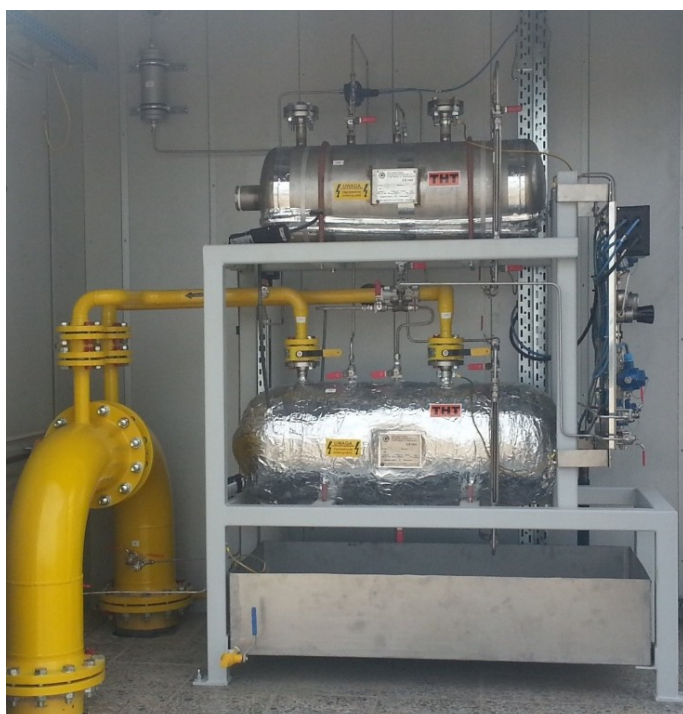
Rys 1: Nawianialnia na stacji SRP LNG Suwałki
