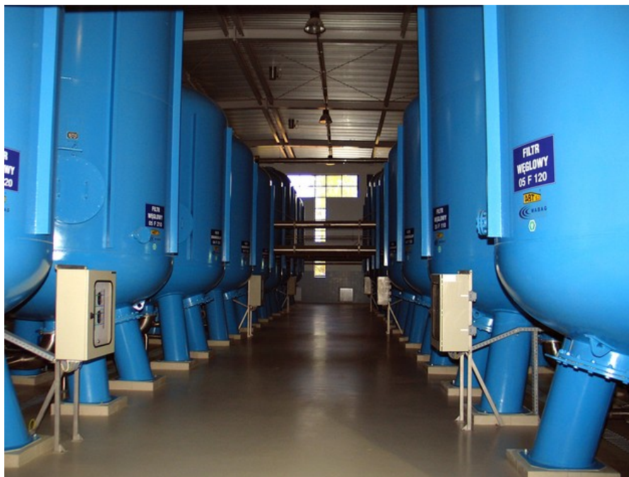
Filtry węglowe na stacji uzdatniania wody w Wierchowisku
